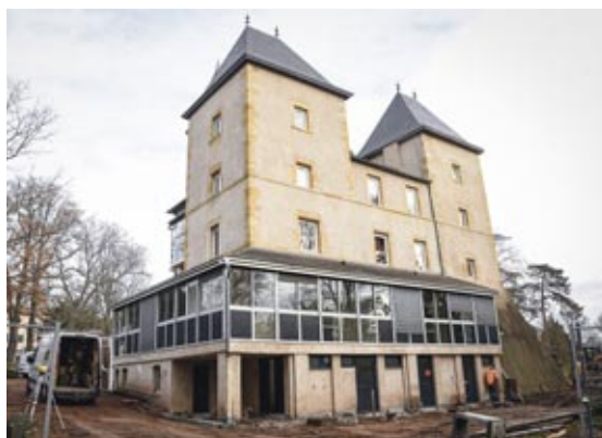
Les travaux se terminent avec le réaménagement des sanitaires du rez-de-jardin.
