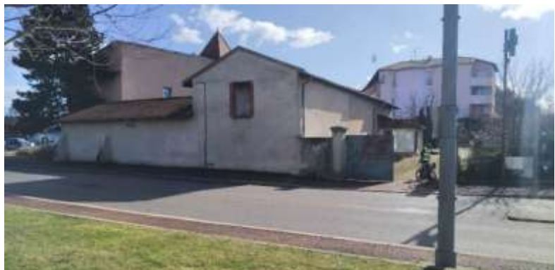
Ancienne ferme qui était localisée sur la parcelle AT0137, repérée au plan de zonage en tant qu'élément caractéristique du paysage sous le n°24 et qui est aujourd'hui démolie.
