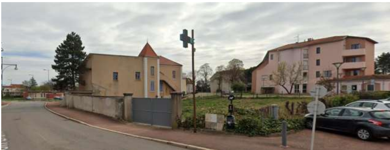
Parcelle AT0137 dans Riorges-Centre, après démolition de l'ancienne ferme qui était repérée au plan de zonage en tant qu'élément caractéristique du paysage sous le n°24.
