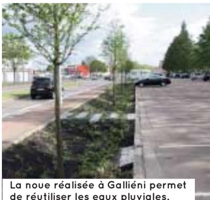
La noue réalisée à Gallieni permet de réutiliser les eaux pluviales.
