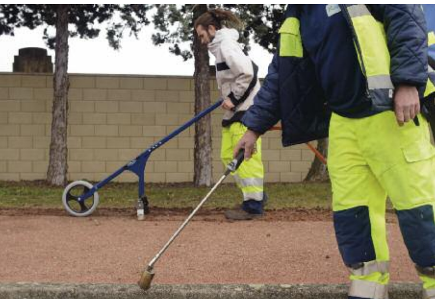
Le désherbage mécanique nécessite des passages réguliers.
