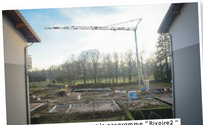
Le chantier est en cours pour le programme " Rivoire2 "
