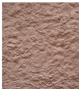
enduit jetée à la truelle
