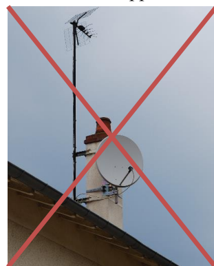
les diverses installations techniques doivent être intégrées à l'architecture
