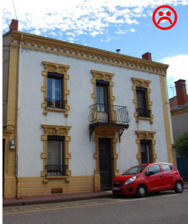
Exemple de menuiseries hétérogènes sur une même façade
