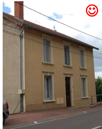
exemple d'une façade qui a conservée sa composition
