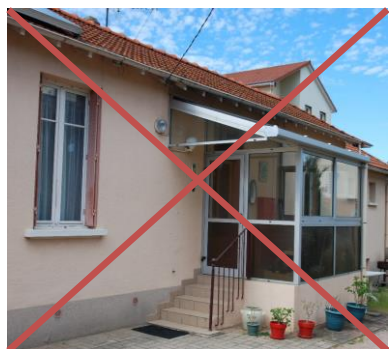
exemple de véranda « lourde » dénaturant l'architecture...
