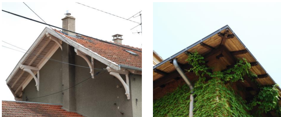
dépassés de toiture traditionnelles avec consoles ouvragées ou chevrons débordants laissant apparente la structure de la couverture
