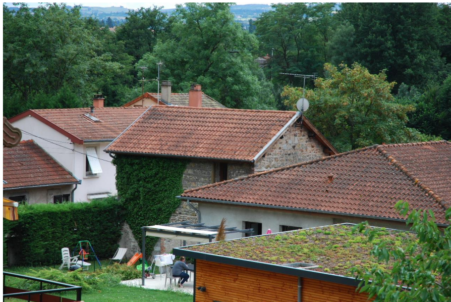
les toitures de Riorges sont essentiellement couvertes en tuiles de terres cuites plates, encore appelées tuiles mécaniques...
