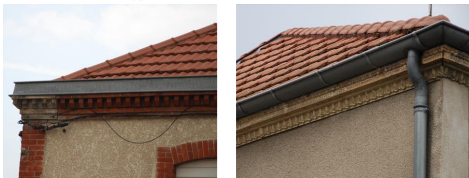
corniches moulurées ou sculptées en terre cuite ou en pierre supportant les chéneaux
