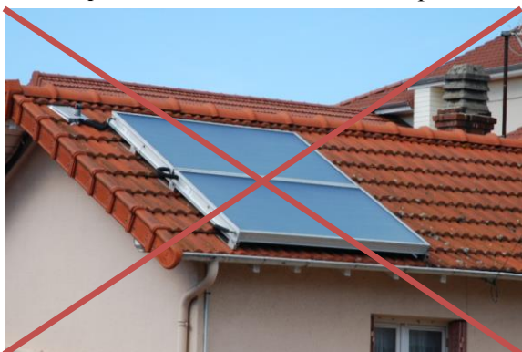
Les panneaux solaires, qu'ils soient thermiques ou photovoltaïques, doivent être intégrés au plan de la couverture...
