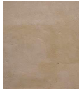
enduit lissé à la truelle
