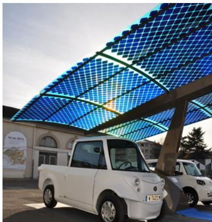
« ombrières » photovoltaïques sur un parking
